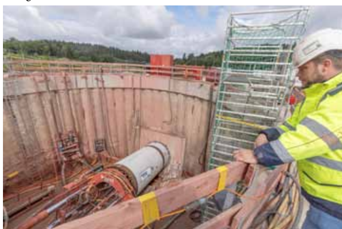
Erdgasleitung bei Lingental, Gasbaustelle 3
