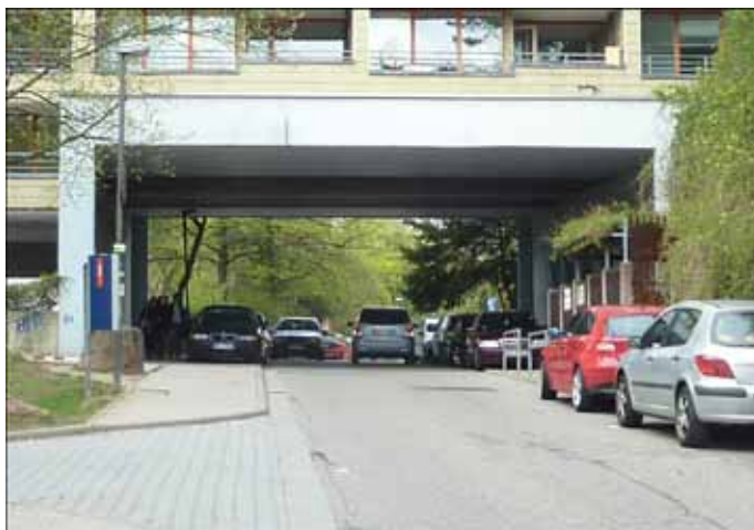
Otto-Hahn-Straße: Da passt doch locker ein Bus durch! Foto: hhh
