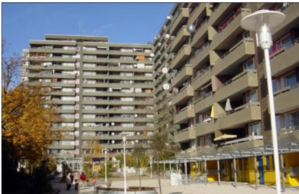
Mit Mitteln aus dem Bund-Länder-Programm „Soziale Stadt“ wurde die Passage saniert. Im Untergeschoss des Gebäudes rechts plante die städtische Gesellschaft für Grund- und Hausbesitz, die GGH, schon lange kleine Gewerbeflächen, die sie jedoch nicht finanzieren könne.
