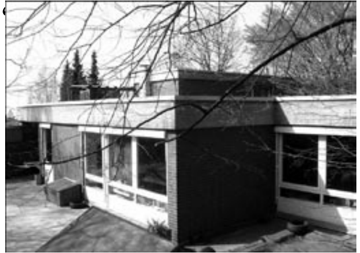
Umbau Kindergarten: Er soll aufgestockt werden.
