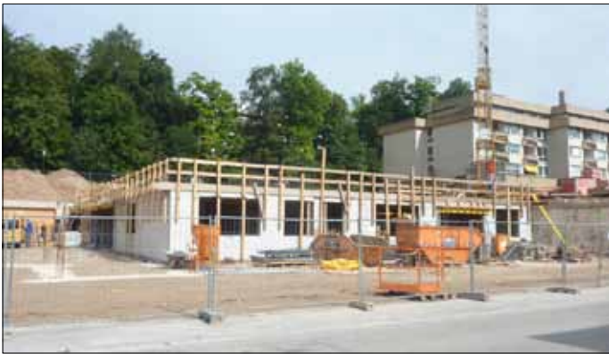
Das Louise-Ebert-Zentrum im Boxberg nimmt Form an.
