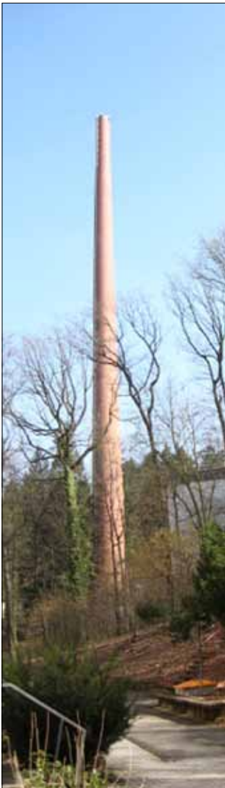
Schornstein des Heizkraftwerks im Boxberg Foto: Herth
