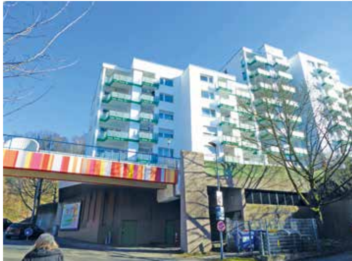
Die renovierten Wohnblocks in der Kleinen Passage
