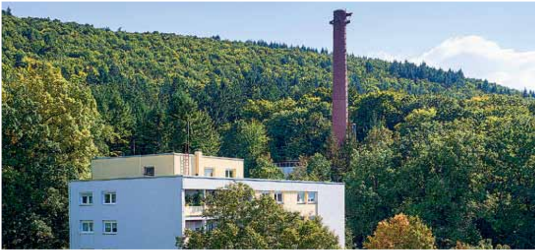
1960 entstand das Heizwerk Boxberg, um die neu gebaute Waldparksiedlung mit 1.800 Wohnungen per Fernwärme zu versorgen. 1971 wurde der Emmertsgrund an das Heizwerk angeschlossen. Foto: Ch. Buck
