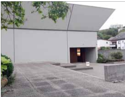
Eingang zum Gebäude, das wie eine Festung wirkt.
